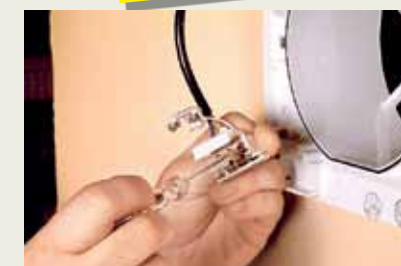
3 Подводят электрические кабели для подключения питания
