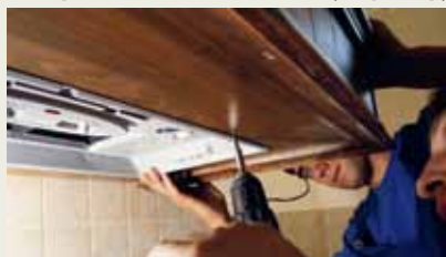
3. Шурупами крепят корпус к коробу
