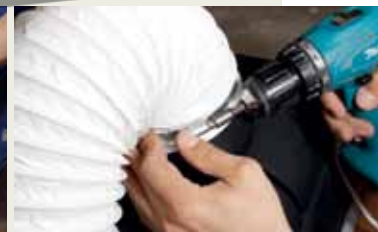
2. К силовому блоку вытяжки подсоединяют воздуховод
