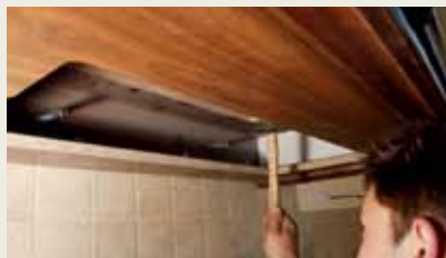
1. Короб навешивают на планку и фиксируют дюбелями
