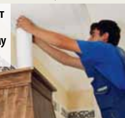
2. К силовому блоку вытяжки подсоединяют воздуховод
