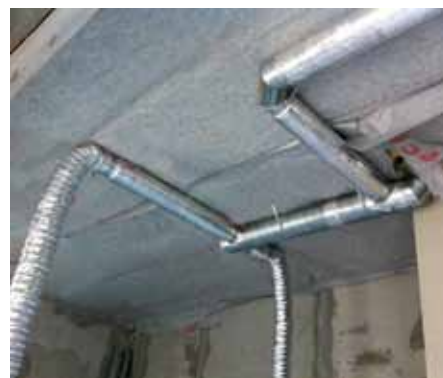
▲ Силовой блок устанавливают в техническом помещении. Воздуховоды распределяют по чердаку, за подвесными потолками, в коробах...
