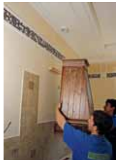
1. Короб навешивают на планку и фиксируют дюбелями
