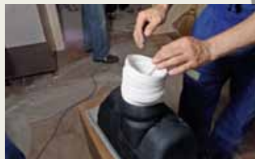
2. К силовому блоку вытяжки подсоединяют воздуховод
