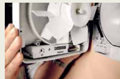
4 Устанавливают основной рабочий блок вентилятора
