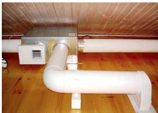
▲ Силовой блок устанавливают в техническом помещении. Воздуховоды распределяют по чердаку, за подвесными потолками, в коробах...
