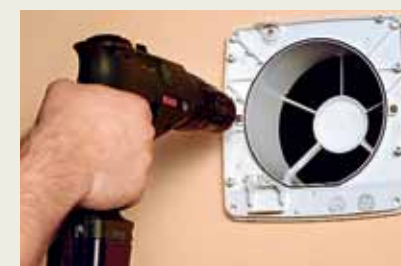
2 Шурупами к стене крепят монтажную коробку
