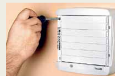
5 Крепят крышку, позволяющую изменять объем воздушного потока
